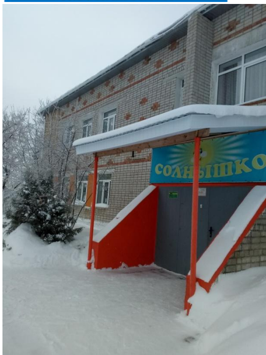
Фото 5 Входная площадка Дверь входная
