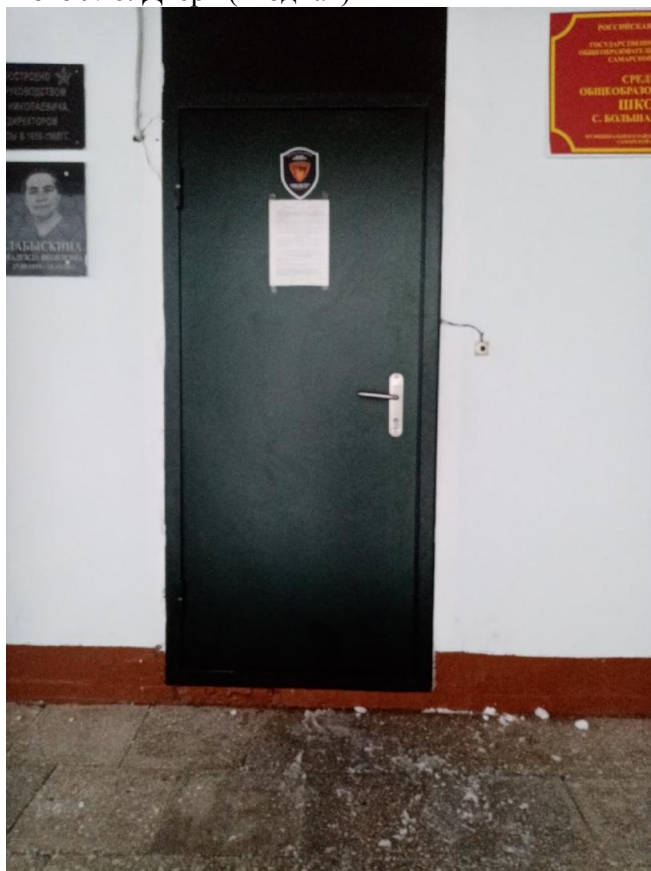
Фото №6. Дверь (входная)
