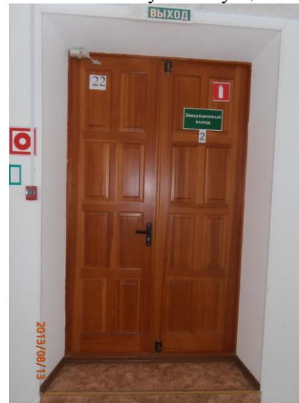
Фото №8. Путь эвакуации.
