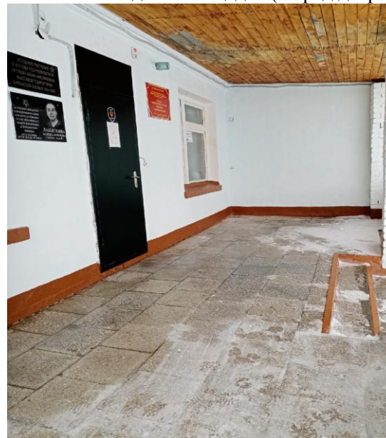
Фото №5 Входная площадка ( перед дверью )
