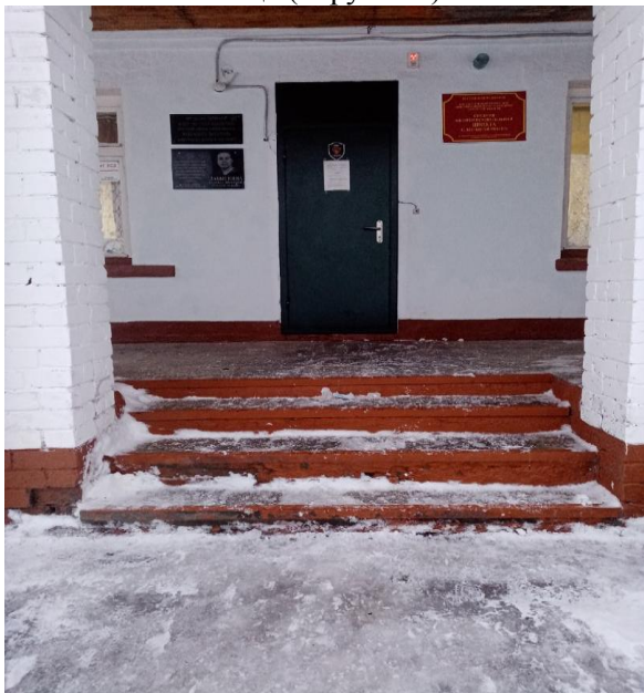
Фото №4 Лестница (наружная)
